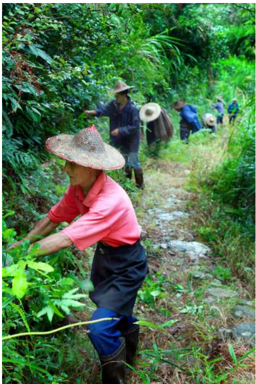
▲村民对古道路面、边坡、沟渠、杂草开展修整清理
